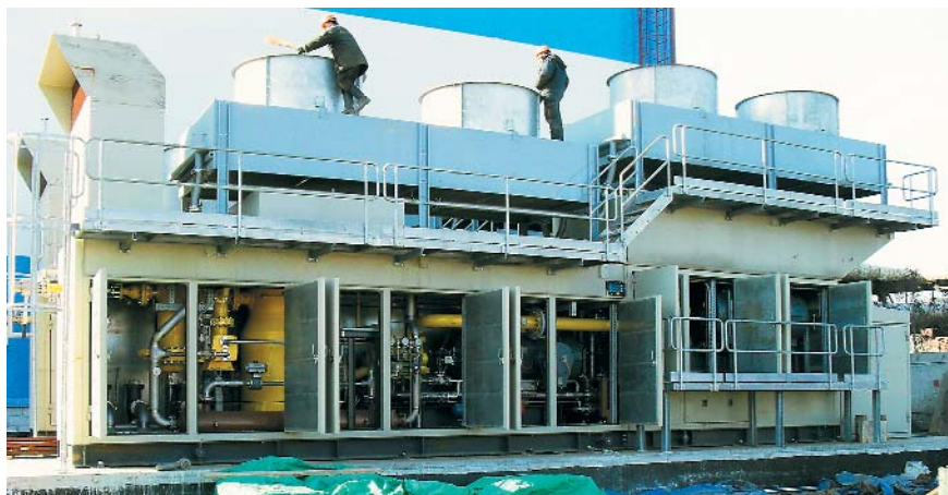
Монтаж дожимных компрессорных установок EGS1-S-300/1000-100/1000 WA
