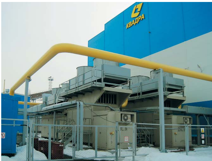
☞ Дожимные установки топливного газа
