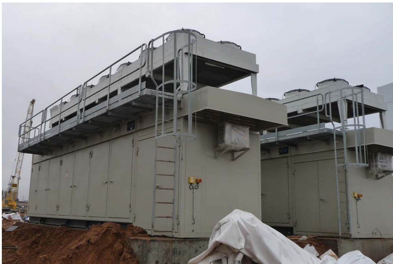
ДКУ ENERPROJECT на стадии шефмонтажных работ
