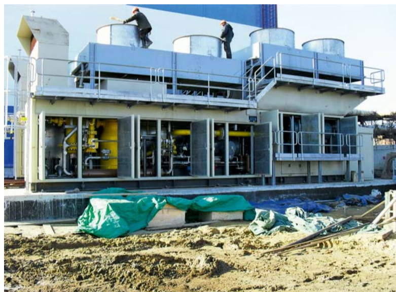
Шефмонтаж ДКУ ENERPROJECT на ПГУ-115 Воронежской ТЭЦ-2
