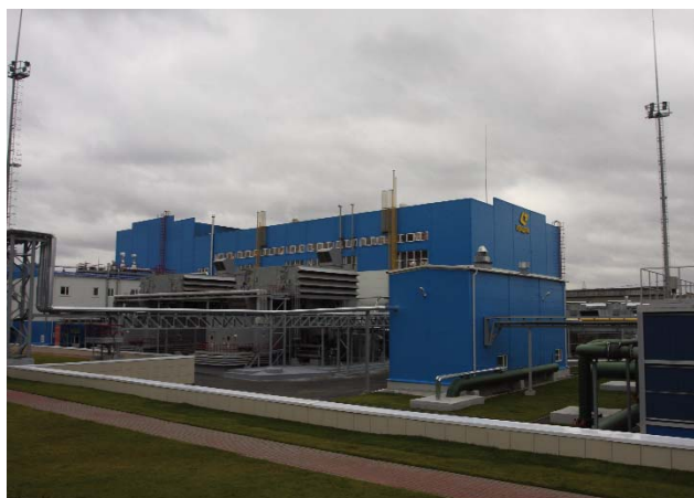
Фото 1. Общий вид ПГУ-115 на Воронежской ТЭЦ-2
