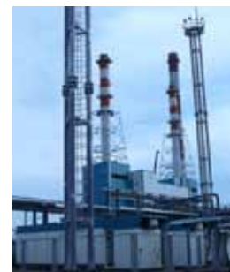
■ ДКУ ENERPROJECT на Белгородской ТЭЦ
