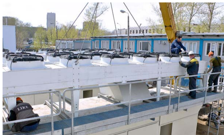
Монтаж дожимной компрессорной станции на ПГУ-ТЭС «Москва-Сити»
