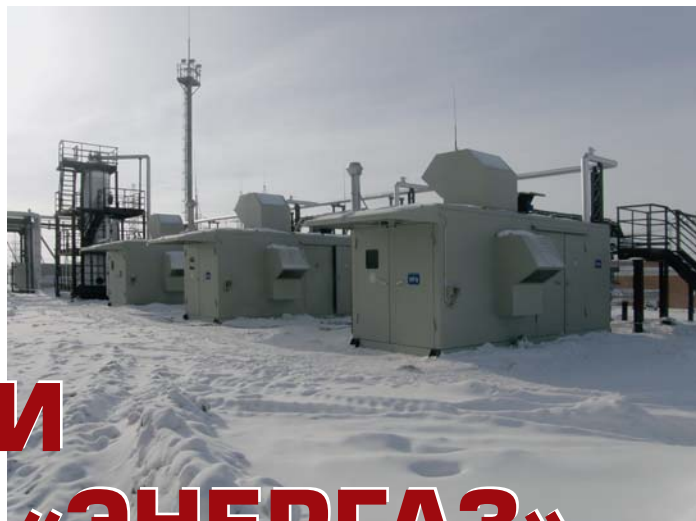
Фото 1. ДКУ Enerproject на НГДУ «Комсомольскнефть» (ОАО «Сургутнефтегаз»)
